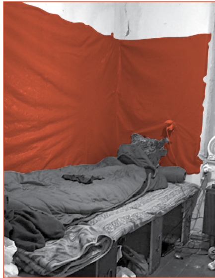
Приклад використання захисної плівки на вологій стіні старого будинку, у якому базувалися бійці
